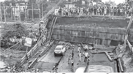
পোস্তার পর মাঝেরহাট ব্রিজ ভাঙ্গা আরেকটি মনুষ্যসৃষ্ট বিপর্যয়ের জ্বলন্ত উদারণ
